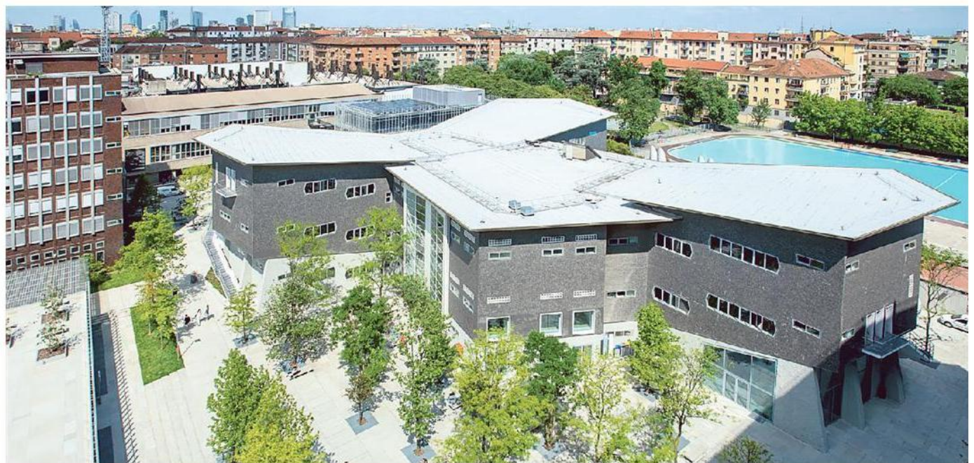
I tre blocchi del nuovo campus di Architettura, che si aggiungono alla ristrutturazione di due edifici di Gio Ponti, la Nave e il Trifoglio
